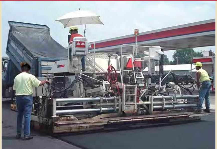
o a diésel de la regla. Las reglas eléctricas están controladas termostáticamente para un ajuste preciso de la temperatura y para proporcionar una operación "sin humo". El sistema de calentamiento a diésel Terex | Cedarapids tiene los quemadores más durables en la industria. Ninguna herramienta se necesita para desmontar o ajustar.
